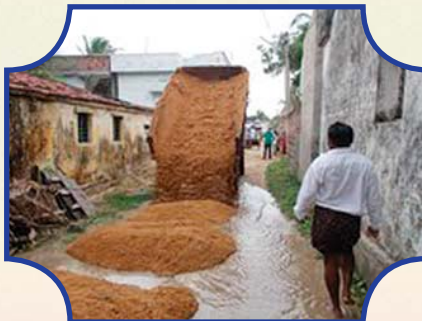
సొంతఖర్చులతో రోడ్డుపై ఉన్న గుంతల్ని ఇసుకతో పూడ్చిస్తున్న కడవకుదురు గ్రామ భారత్ నిర్మాణ వాలంటీర్లు
